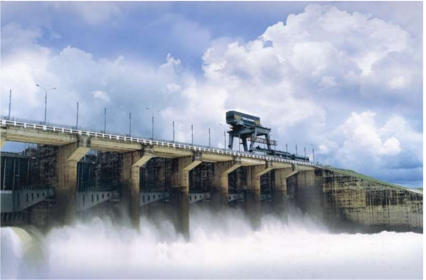
Nhà máy Thủy điện Trị An
