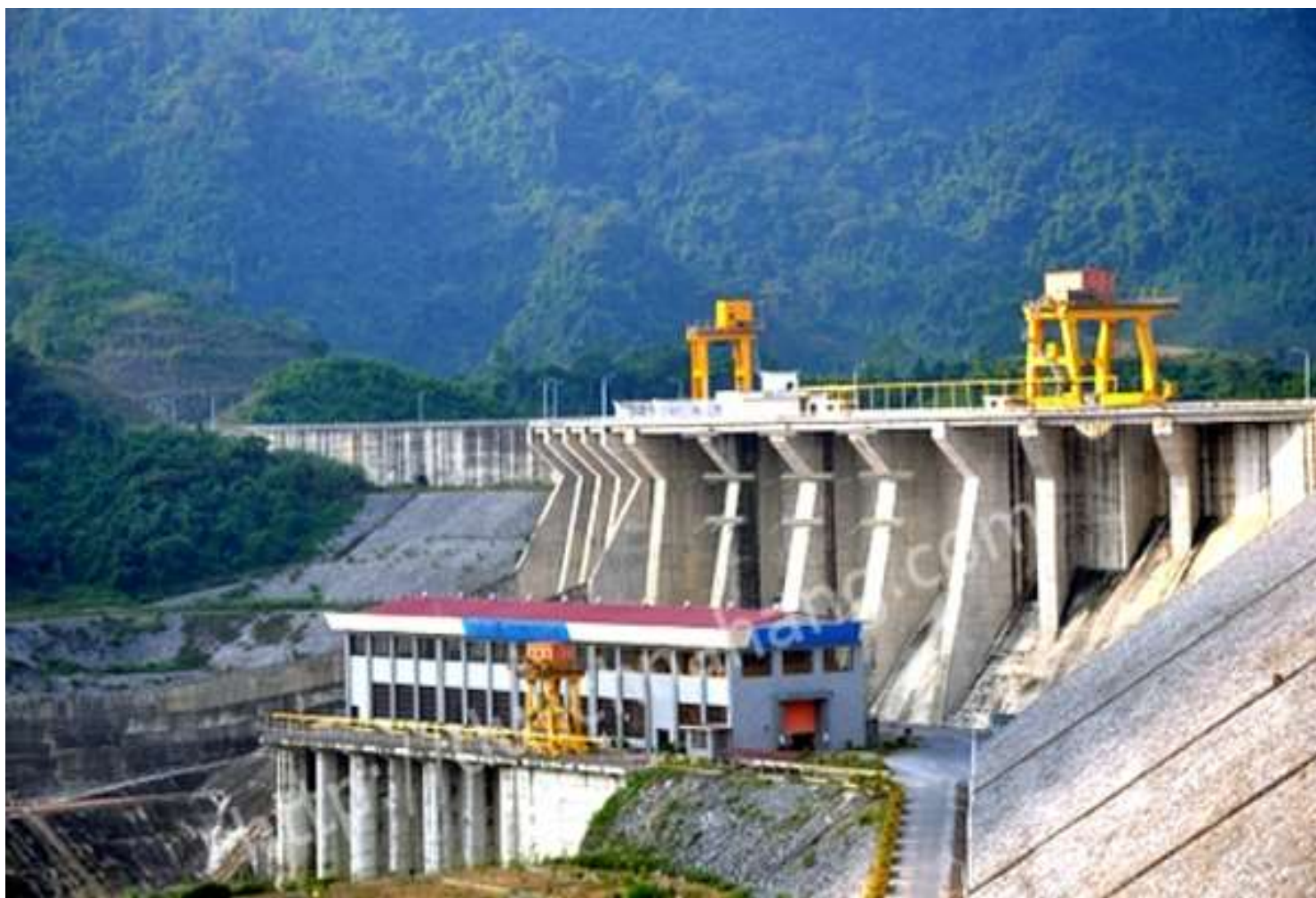
Nhà máy thủy điện Na Hang (Tuyên Quang)
