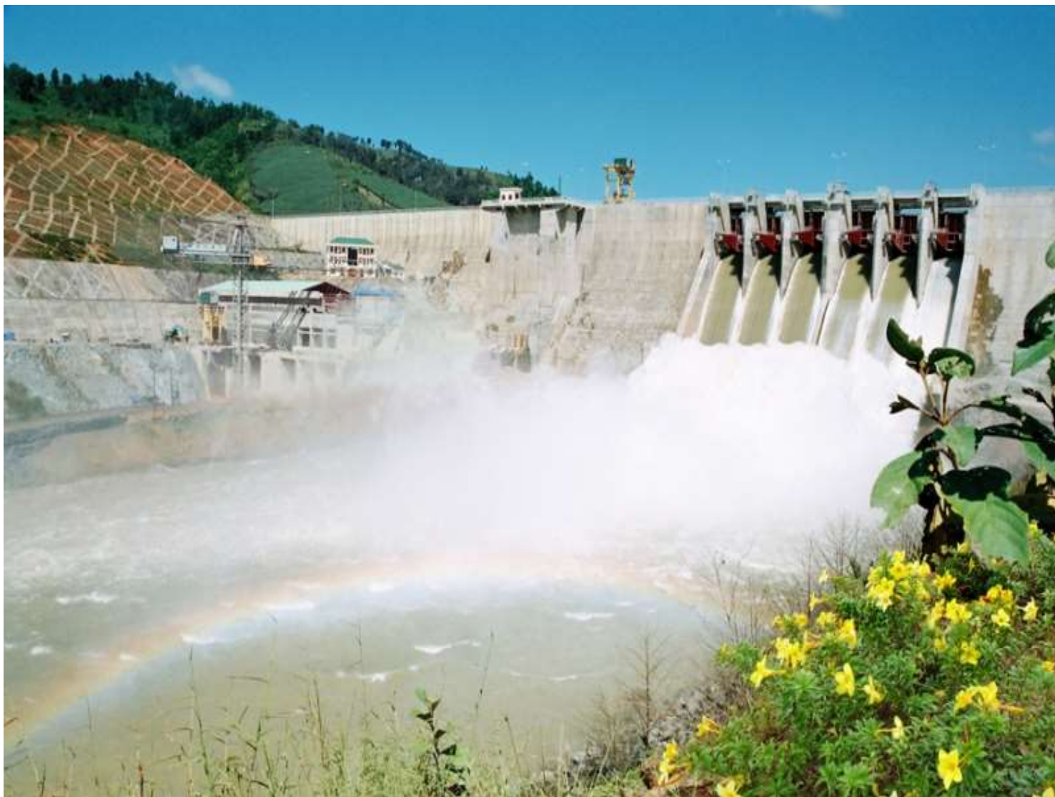
Nhà máy thủy điện Yaly
