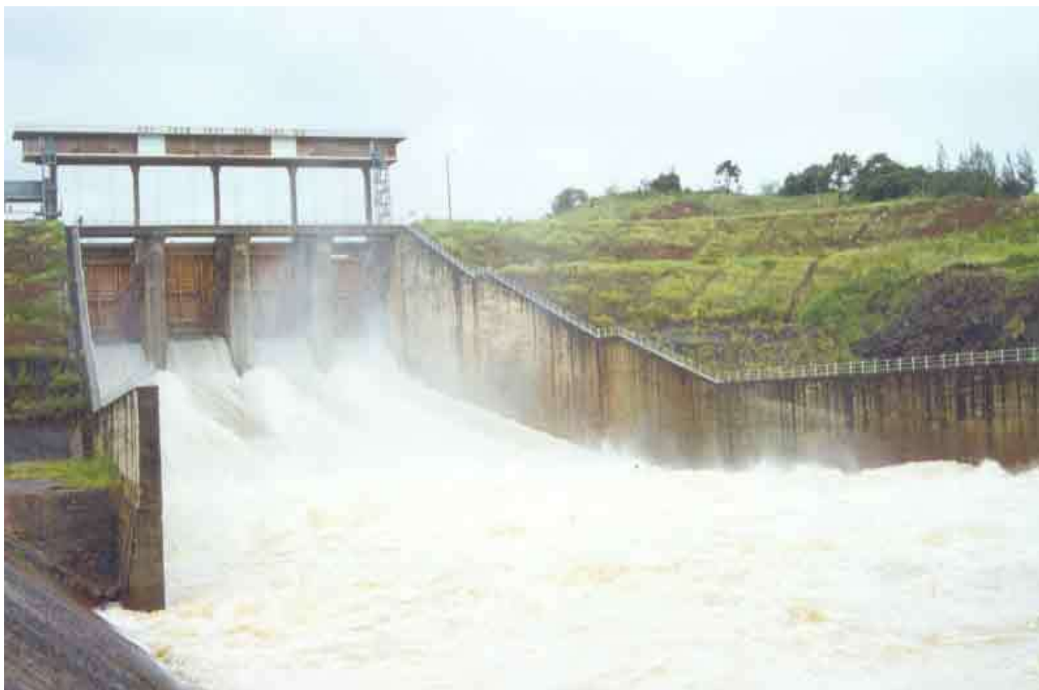
Nhà máy thủy điện Thác Mơ
