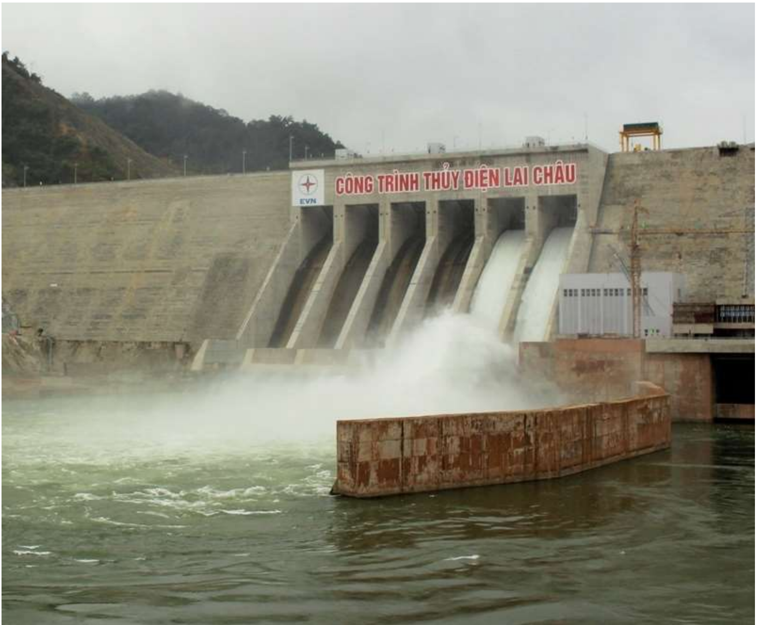
Nhà máy thủy điện Lai Châu
