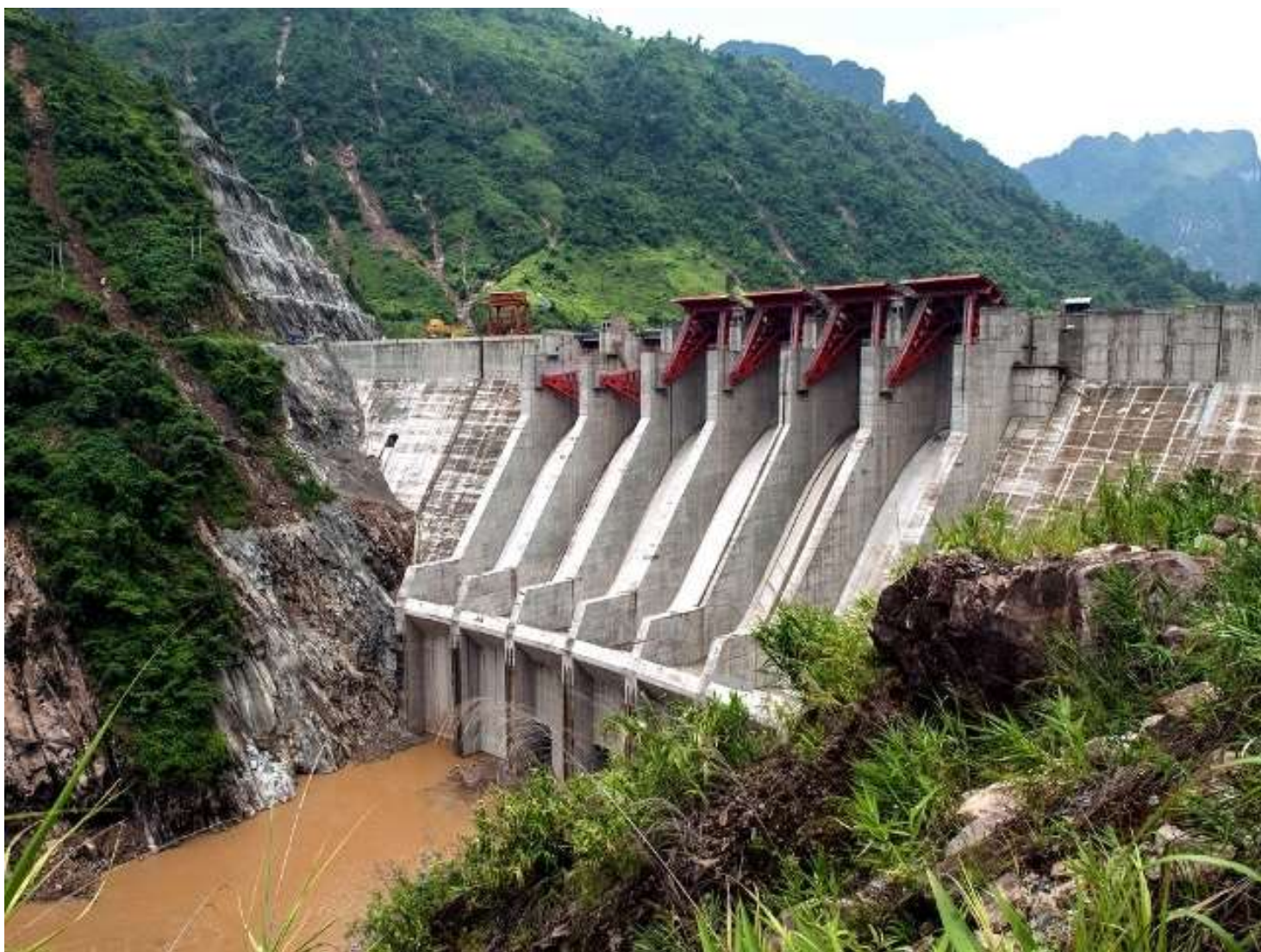
Nhà máy Thủy điện Huội Quảng
