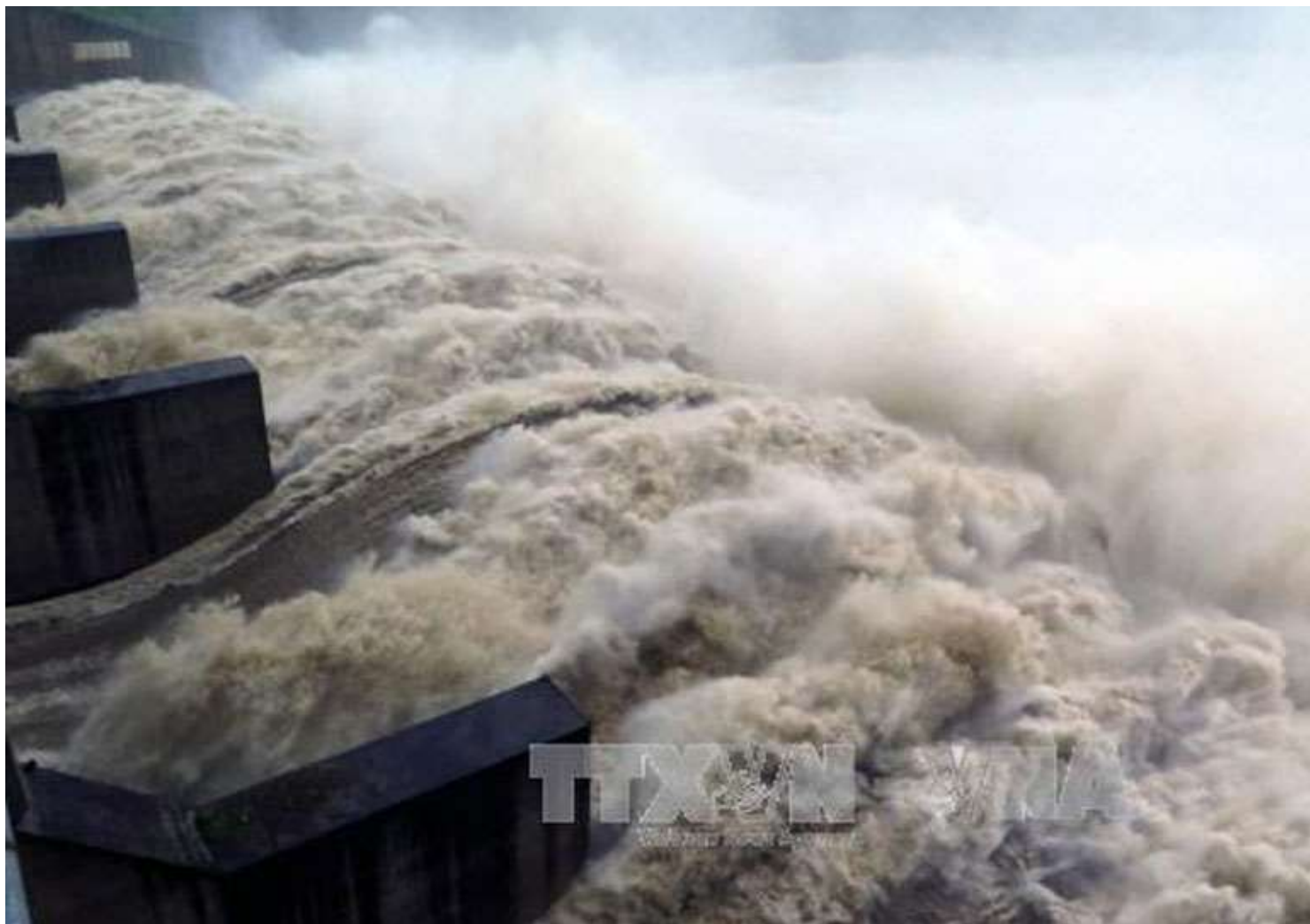
Thủy điện Sông Ba Hạ
